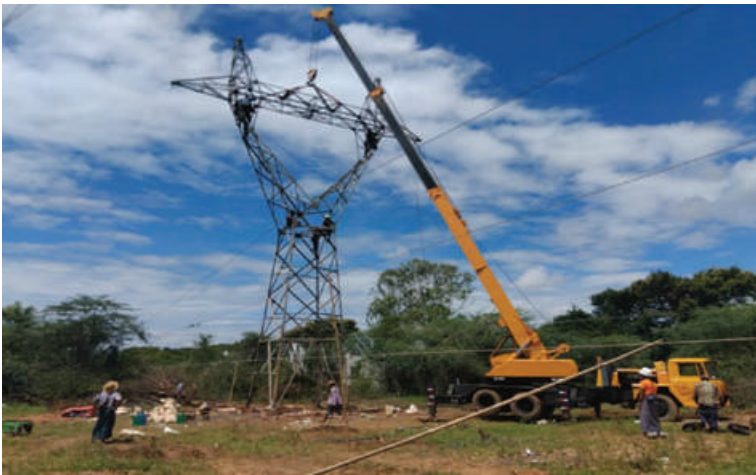
၁၃၂ ကေစီ ညောင်ပင်ကြီး-ဗုဒ္ဓကုန်း ဓာတ်အားလိုင်း တာဝါတိုင်အမှတ်(၃၃၈) ဖောက်ခွဲဖျက်ဆီးခံရမှုကြောင့် ပြိုလဲပျက်စီးမှုကို ပြန်လည်ပြုပြင်ခြင်းလုပ်ငန်းဆောင်ရွက်မှုမှတ်တမ်းဓာတ်ပုံ။
