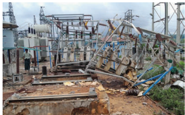
လားရှိုးမြို့ ၆၆ကေစီ ဓာတ်အားခွဲရုံနှင့် ၃၃ကေစီ ဓာတ်အားခွဲရုံများတွင် ဓာတ်အားခွဲရုံပစ္စည်းများ ပျက်စီးနေမှု မှတ်တမ်းဓာတ်ပုံ။
