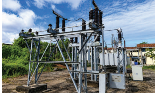
သီပေါမြို့နယ် ၃၃/၁၁ကေစီ ၁၀ အမ်ပီအေ သီပေါဓာတ်အားခွဲရုံတွင် ပျက်စီးနေသော ဓာတ်အားခွဲရုံပစ္စည်းများ အသစ်အစားထိုးပြုပြင်တည်ဆောက်ခြင်း မှတ်တမ်းဓာတ်ပုံ။
