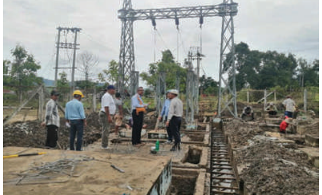
ကယားပြည်နယ် လွိုင်ကော်မြို့ ၃၃/၁၁ ကေစီ ၅ အမ်ပီအေ ကယန်းသာယာဓာတ်အားခွဲရုံ Control Room အတွင်း ပျက်စီးနေမှု (အပေါ်ပုံ)နှင့် ပြန်လည်ပြုပြင်နေမှု(အောက်ပုံ) မှတ်တမ်းဓာတ်ပုံ။
