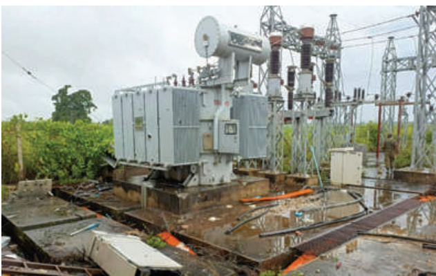
နောင်ချိုမြို့နယ် ၃၃/၁၁ကေစီ ၁၀ အမ်ပီအေ ရွှေညောင်ပင်ဓာတ်အားခွဲရုံတွင် ဓာတ်အားခွဲရုံပစ္စည်းများ ပျက်စီးနေမှု(ဝဲပုံ)နှင့် ပြန်လည်ပြုပြင်နေမှု(ယာပုံ) မှတ်တမ်းဓာတ်ပုံ။
