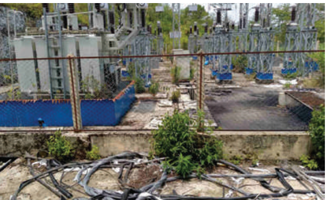
၆၆/၁၁ ကေစီ ၅ အမ်ပီအေ ဖလမ်းဓာတ်အားခွဲရုံ ပျက်စီးဆုံးရှုံးမှု မှတ်တမ်းဓာတ်ပုံများ။
