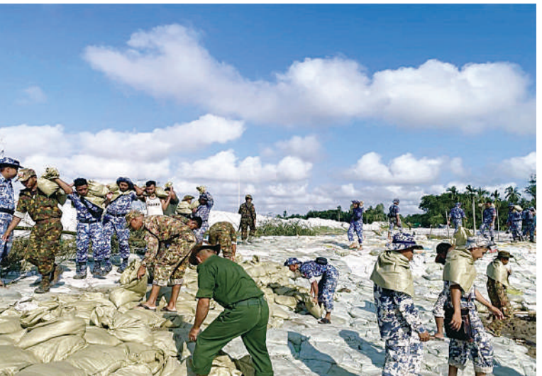
နယ်မြေခံတပ်မတော်သားများက ညောင်တုန်းကျွန်းတာ(ဧရာဝတီမြစ်ခွဲ) တာကိုယ်ထည်တိုက်စားခံရမှု တားဆီးကာကွယ်ရေးလုပ်ငန်းများ ဆောင်ရွက်ကြစဉ်။
