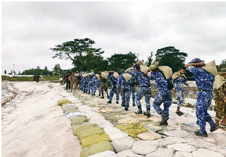
နယ်မြေခံတပ်မတော်သားများက ညောင်တုန်းကျွန်းတာ(ဧရာဝတီမြစ်ခွဲ) တာကိုယ်ထည်တိုက်စားခံရမှု တားဆီးကာကွယ်ရေးလုပ်ငန်းများ ဆောင်ရွက်ကြစဉ်။
