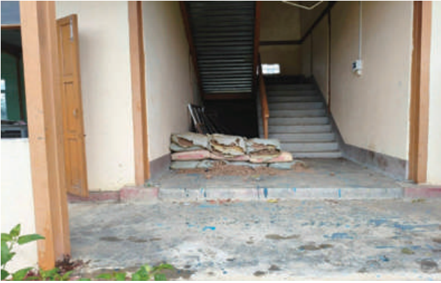
တပ်မတော်စစ်ကြောင်းများက ရန်လင်းဖိုင်ရွာကို ရှင်းလင်းစဉ် အကြမ်းဖက်သောင်းကျန်းသူများက နေအိမ်များ၊ ဌာနဆိုင်ရာအဆောက်အအုံများ အကာအကွယ်ပြုလုပ်၍ ခံစစ်ကျင်းများ၊ ဘန်ကာများပြုလုပ်ကာ စစ်စခန်းအဖြစ်အသုံးပြုထားမှု မှတ်တမ်းဓာတ်ပုံ။
