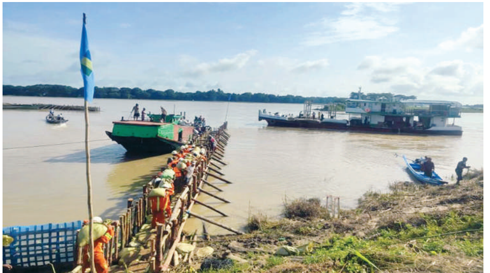
မီးသတ်တပ်ဖွဲ့ဝင်များ၊ လူမှုကယ်ဆယ်ရေးအဖွဲ့များ၊ ပရဟိတအဖွဲ့များက မြစ်ရေတိုက်စားပြီးကျမှုမှ ကာကွယ်ရန် ကမ်းထိန်းအိတ်များချခြင်း၊ ရေရှိန်တားပြုလုပ်ခြင်းတို့ ဆောင်ရွက်ပေးစဉ်။
