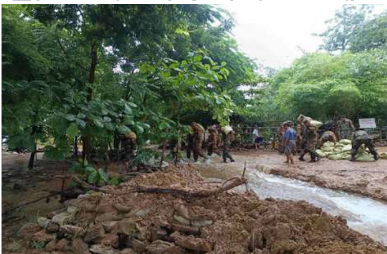
ရွှေဘိုတပ်နယ်မှတာဝန်ရှိသူများ၊ အရာရှိ၊ စစ်သည်များက ကိုးပင်ရေလှောင်တံစံ၏ မြေထိန်းနံရံအတွင်းသို့အားဖြည့်သံအိတ်များနှင့်မြေစာအိတ်များဖြည့်တင်းရေးလုပ်ငန်း ဆောင်ရွက်ပေးစဉ်။
