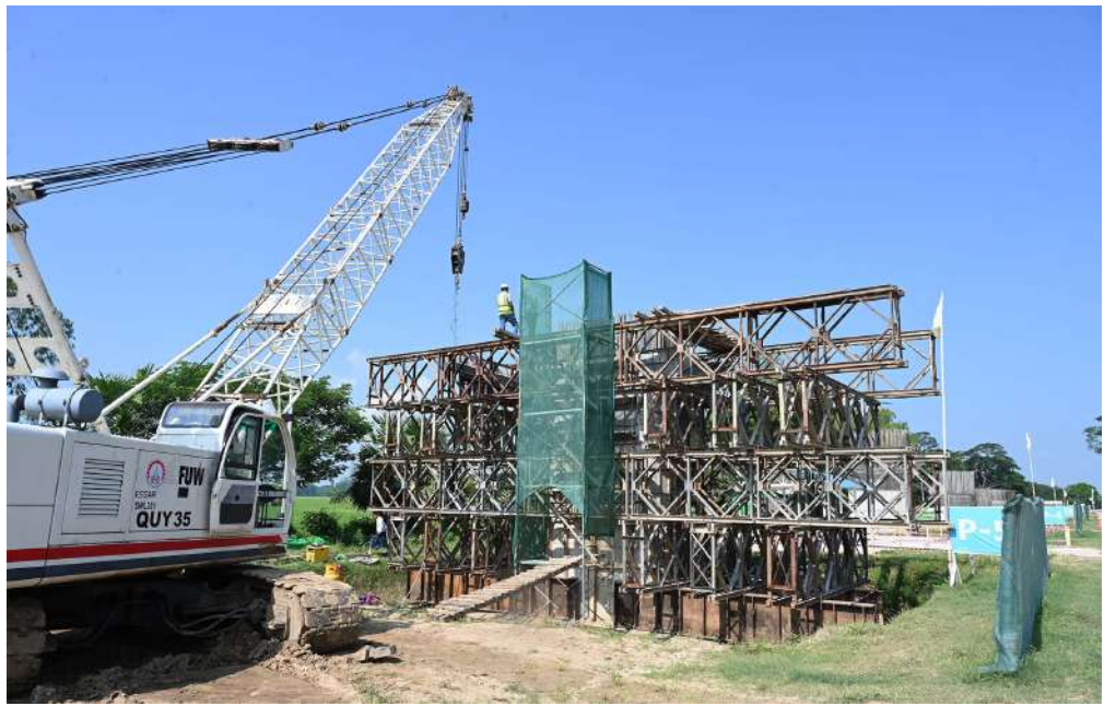
ရွှေပြည်တော်ဝင်လမ်းပေါ်ရှိ နေပြည်တော်-တောင်တွင်းကြီး မီးရထားလမ်း ခုံးကျော်တံတားတည်ဆောက်ရေး လုပ်ငန်းခွင်ကို တွေ့ရစဉ်။
