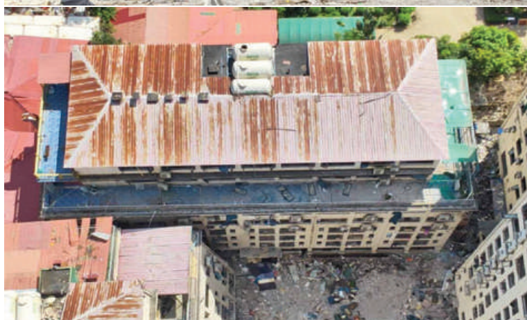
ရွှေကုက္ကိုလ်နယ်မြေ ဒုတိယပိုင်းအတွင်းရှိ အွန်လိုင်းလောင်းကစားမှုကျူးလွန် ရာတွင် အသုံးပြုသည့် တရားမဝင် ခြောက်ထပ် အဆောက်အအုံကို မဖြိုဖျက်မီ တွေ့ရစဉ်။
